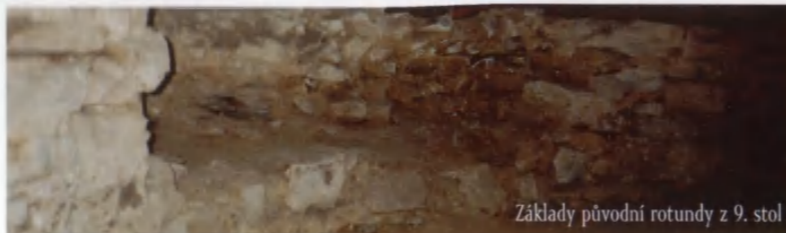
Základy původní rotundy z 9. stol
